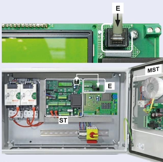
ST 63 dans une armoire métallique avec module (E) et centrale de commande (MST) pour verrou électrique intégré
